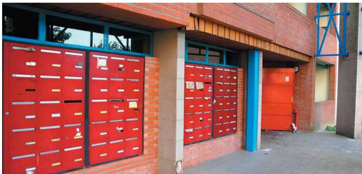
Bientôt de nouvelles boîtes aux lettres dans des halls rénovés.
